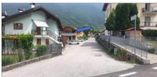
Strada di accesso all'immobile oggetto di pignoramento
